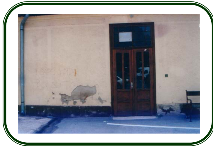
Kako je izgledao ulaz prije obnove prostora.....
